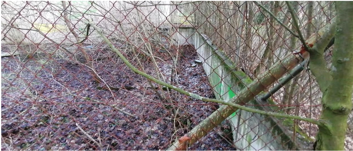
Abbildung 17: Rückzubauender Bereich mit unterirdischem Bauwerk, Zaun und Mauern neben dem Heizhaus in Beichlingen. Foto: A. Hölzer 2025
