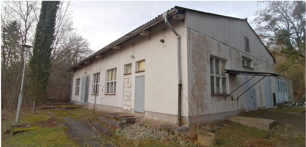
Abbildung 14: Abzureißendes Heizhaus in Beichlingen mit Außenanlagen. Foto: A. Hölzer 2025
