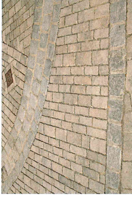
Beispiel Gehwegpflasterung mit „Via Castello“, Kleinpflaster, Rinne und Einzeiler aus Naturstein
