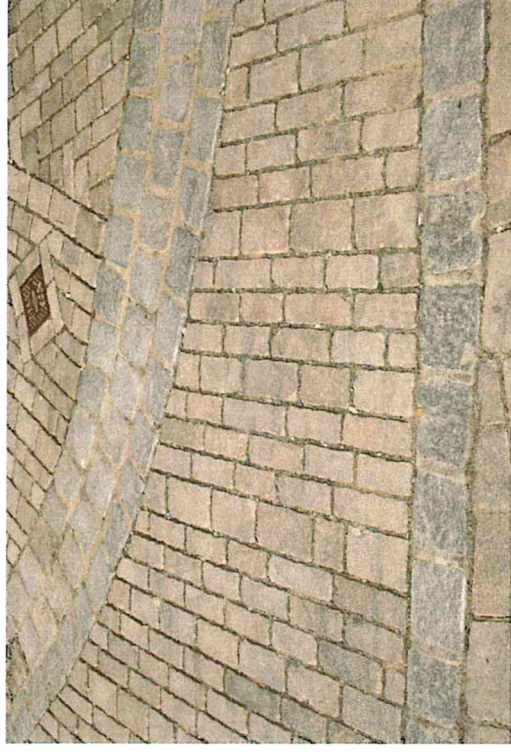
Beispiel Gehwegpflaster mit „Via Castello“, Kleinpflaster, Rinnen Naturstein
