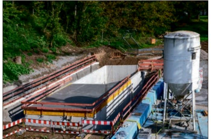
Auch am Becken tut sich einiges: Die Sprunggrube wurde auf die erforderliche Tiefe für den neuen Sprungturm gebracht, bald kann der Dreier errichtet werden. Und aktuell laufen die ersten Vorbereitungen für die Beckenschalung.
