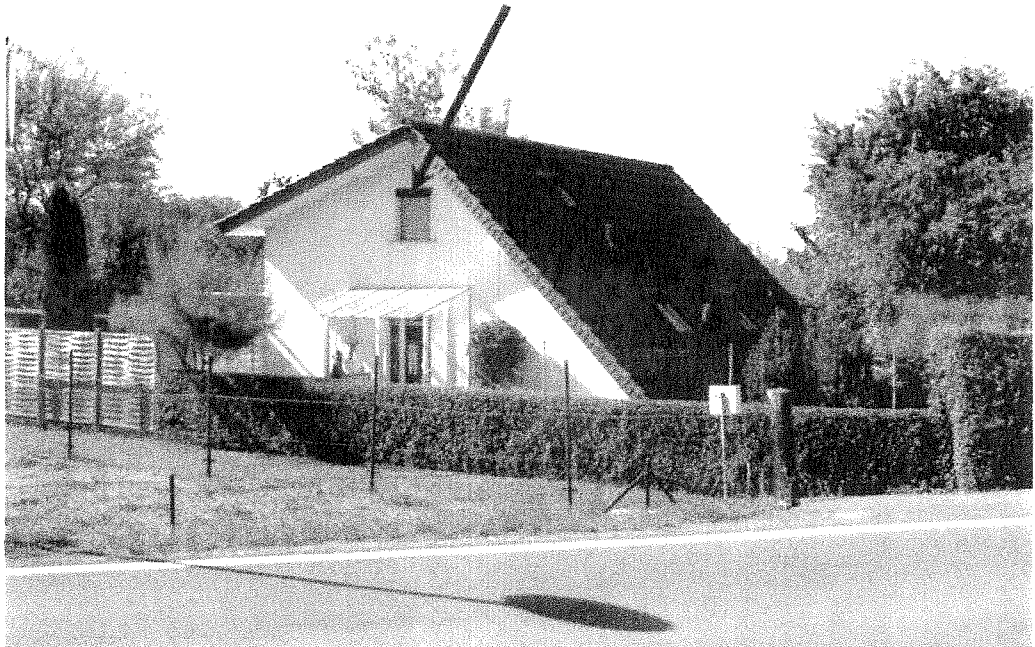
Foto 13: Blick auf die Ostfassade (Pfeil) des Wohngebäudes IO 9 „Weimarische Straße 2“. Die rückwärtige West-Fassade zeigt in Richtung des geplanten SB-Marktes.
