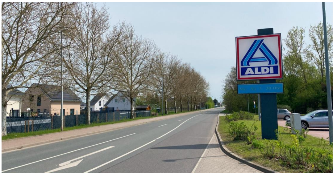
Abbildung 3: Blick entlang der Weimarische Straße in Richtung Südosten/Ortsausgang
