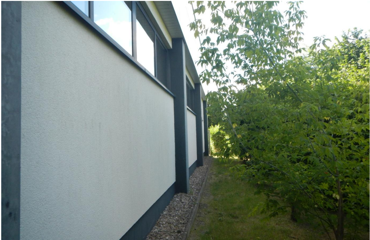
Abb. 13: Westseite: Blick Richtung Süden auf Fassade und Gehölze
