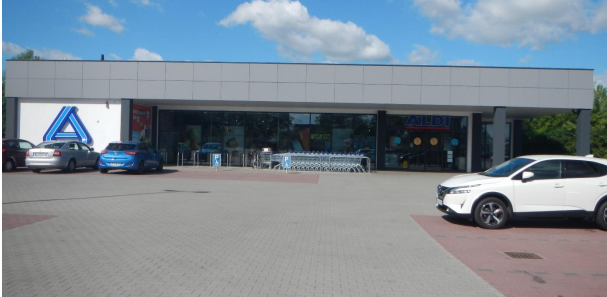
Abb. 5: ALDI-Markt Kölleda, nach Osten gerichtete Eingangsseite
