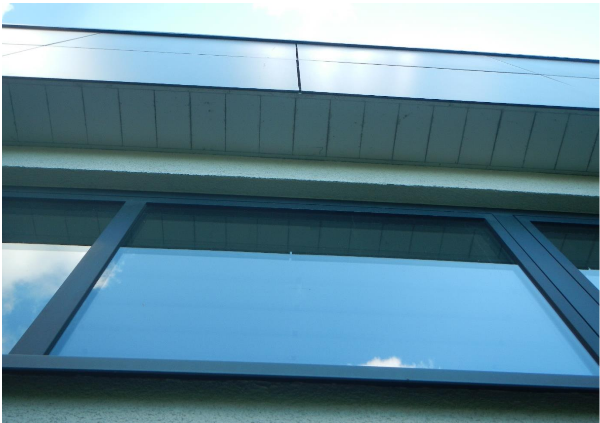
Abb. 11: Dach- und Fensterabschlüsse ohne Spaltenstrukturen
